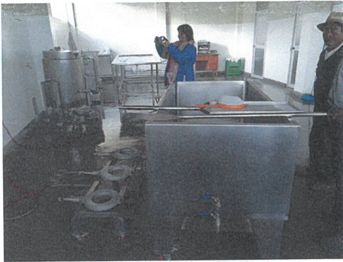
Vista de la planta de El Tingo
